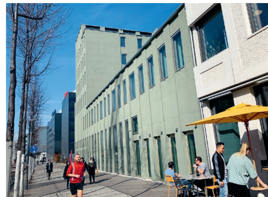
Das Bildungszentrum an der Pflingstweidstrasse in Zürich: Der Abschluss der Bauarbeiten ist absehbar, die Einweihung für Anfang 2020 geplant. Foto: Lukas Bernays
